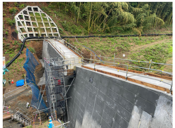
砂防堰堤（さぼうえんてい・砂防ダム） 工事現場の写真
