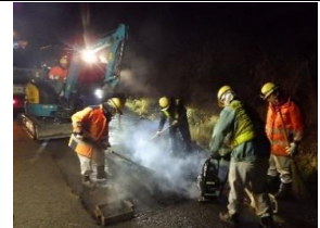
(舗裝修繕工事)
