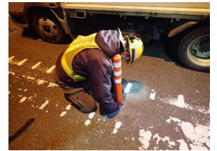
(道路附属物工事)
