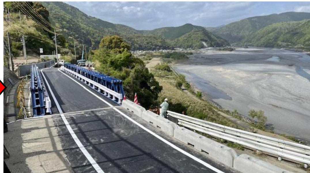
仮設道路設置後
